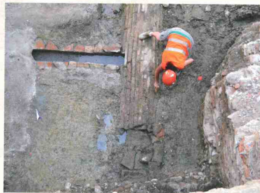
In alto: lo scavo di un grande condotto fognario scoperto nell'area di Palazzo Busetti. Orientato in senso nord-sud, convogliava le acque in direzione sud, verso la cloaca principale posta sotto la via Emilia. In basso, sulle due pagine: una veduta del centro storico di Reggio Emilia.
